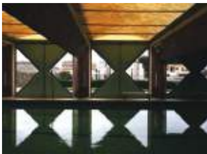
Fig 24. Photo de la piscine du Fango avant les travaux de réfection de la toiture, Auteur: FTViaStella
