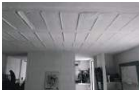
Les hourdis du plafond intérieur dans le salon, Source: Clément-Gaillard
